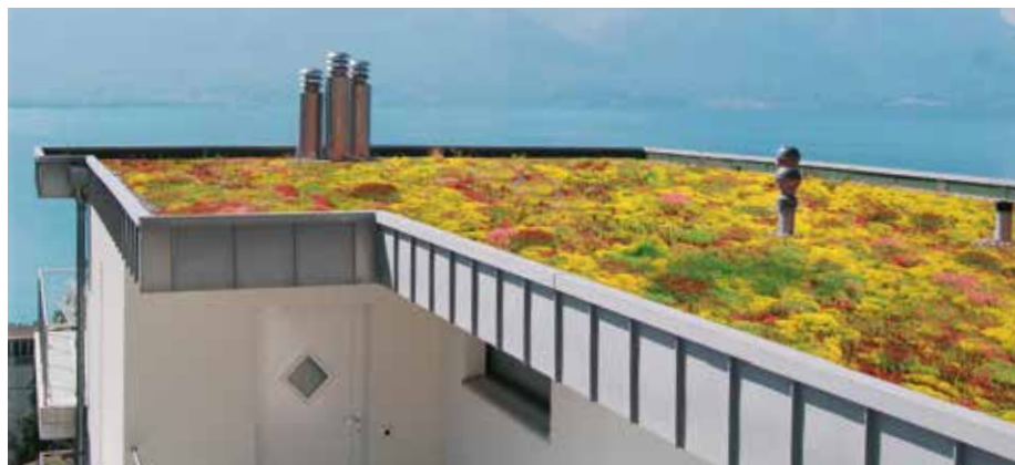
Coberturas Verdes extensivas
